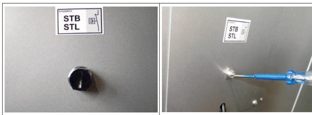
Dès que la température chute en dessous de 75 °C environ, le limiteur de température de sécurité peut être déverrouillé mécaniquement :
