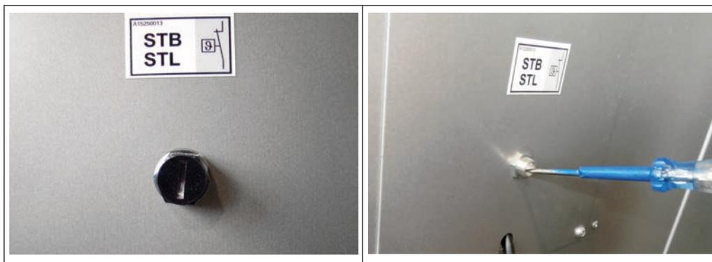
Una vez que la temperatura ha descendido por debajo de aprox. 75 °C, el termostato de seguridad se puede desbloquear mecánicamente.
